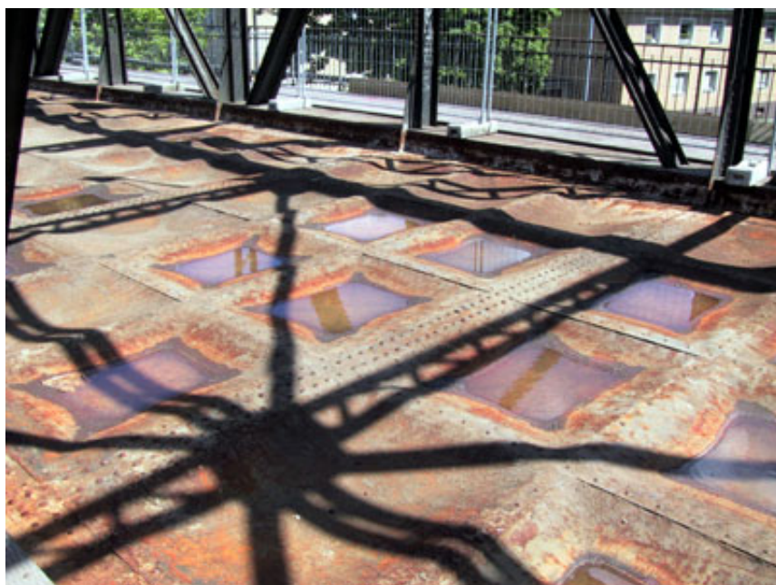
Abschied 2002: Die Bürgerbrücke ist abgerissen...
